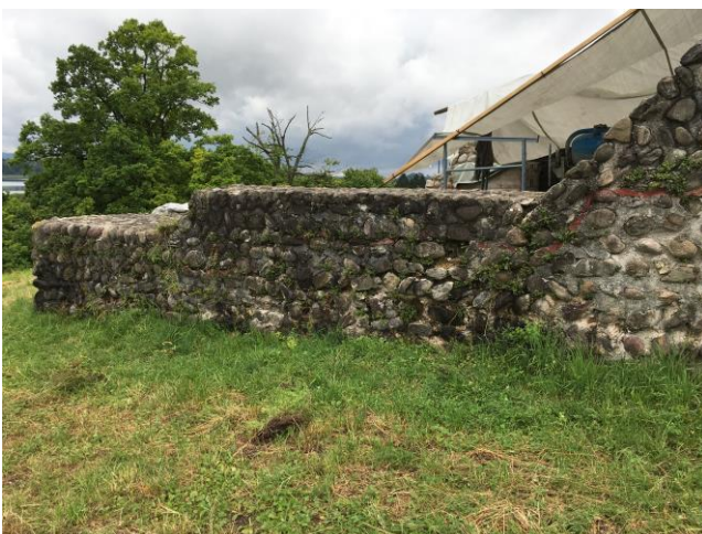
Abbildung Nr.11, Ostseite Turm 2 aussen, alt
