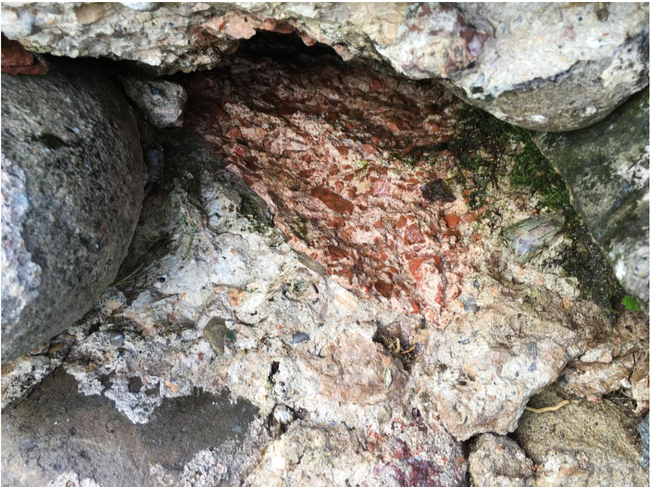
Abbildung Nr. 6, Detailansicht des opus signinum
