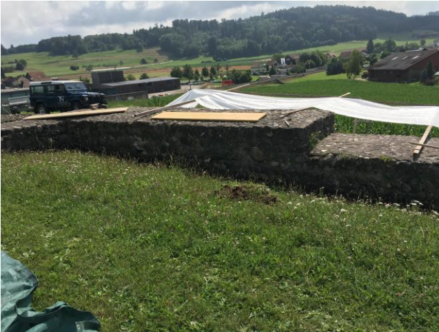
Abbildung Nr. 25, Ostseite innen zw. Turm 2 und Eingang 1, alt
