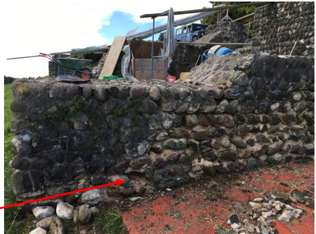
Abbildung Nr. 5, Ansicht der Mauer mit opus signinum
