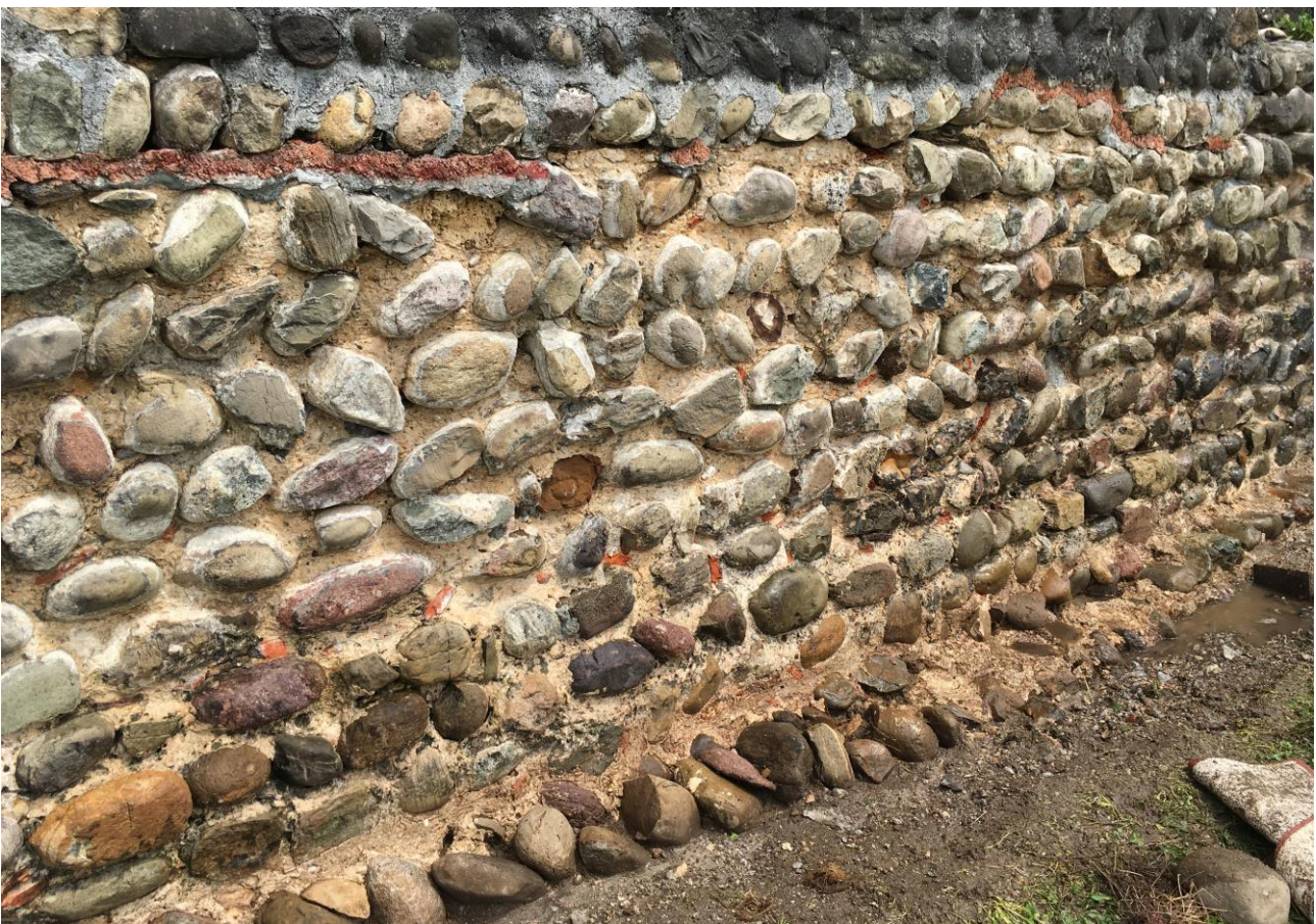
Abbildung Nr.3, Ansicht eines Mauerabschnitts nach der Reinigung.
