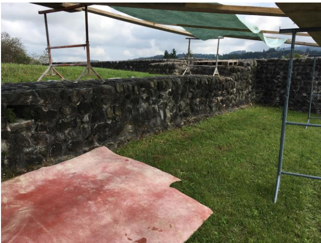
Abbildung Nr. 29, Ostseite aussen zw. Eingang 1 und Turm 8, alt
