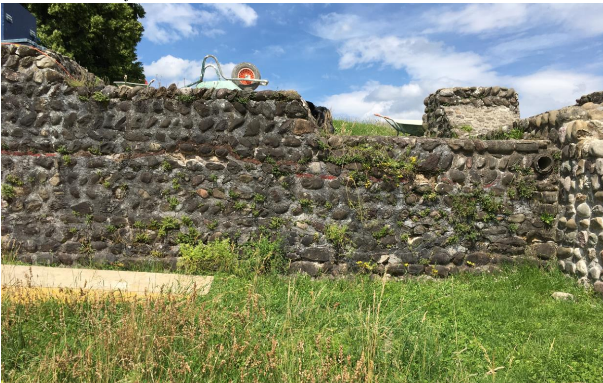
Abbildung Nr. 2, Ansicht des südwestlichen Mauerabschnitts anschliessend an Turm 2
