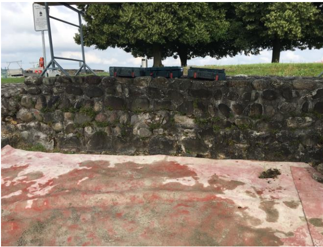
Abbildung Nr. 27, Ostseite aussen zw. Eingang 1 und Turm 8, alt
