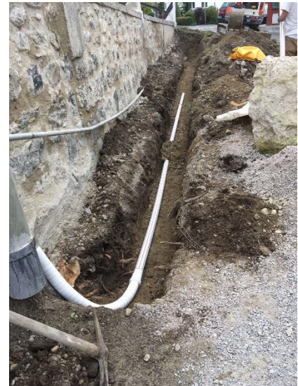
Abbildung 20: Neu verlegte Stromleitung.
