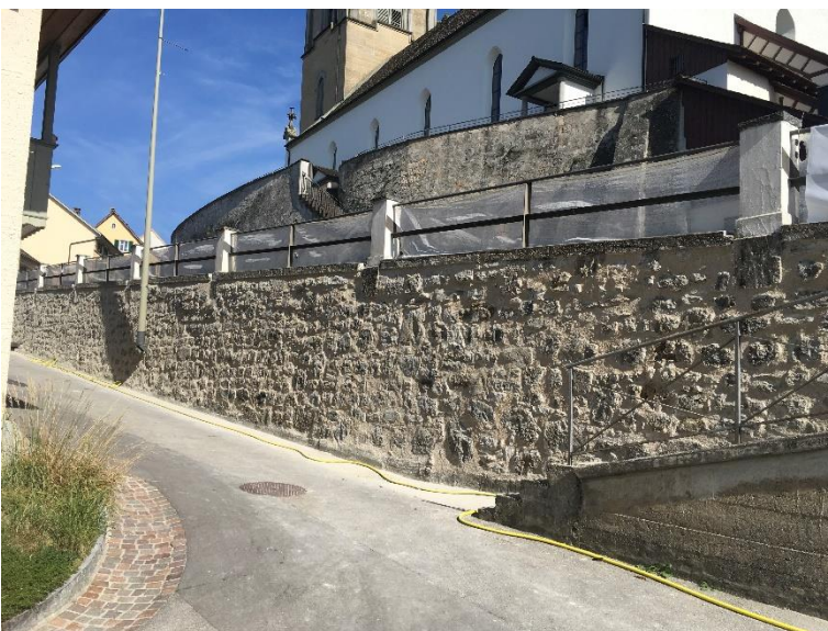
Abbildung 10: Ansicht der verputzten Mauer nach dem Kratzen.
