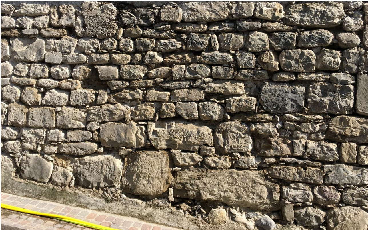
Abbildung 6: Das Mauerbild entstand erst nach dem Eliminieren des Zementputzes und dem Reinigen der Mauer.
