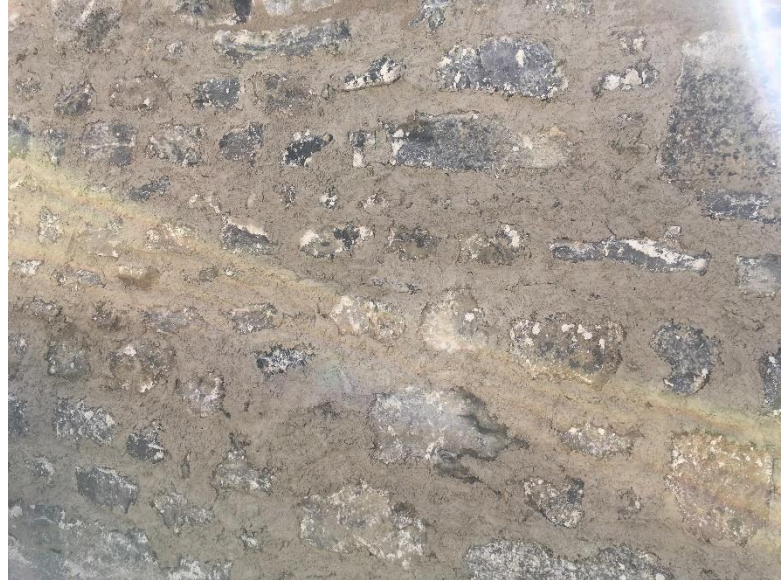
Abbildung 10: Der Mörtel, mit der Kelle angeworfen und Steinköpfig abgezogen.
