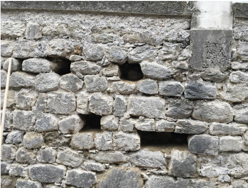
Abbildung 7: Ansicht eines Mauerabschnitts vor dem zumauern der Löcher.
