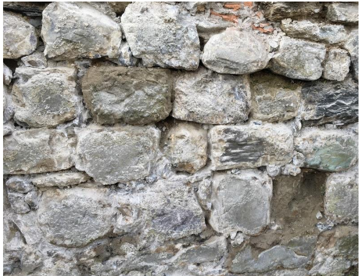
Abbildung 5: Ansicht der vom Zementputz befreiten Mauerwerk.
