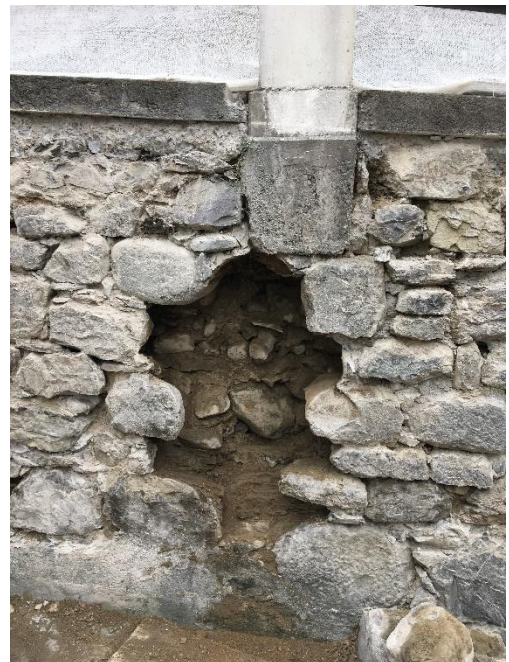
Abbildung 8: Auch grössere Löcher, mussten zuerst komplett vermauert werden.
