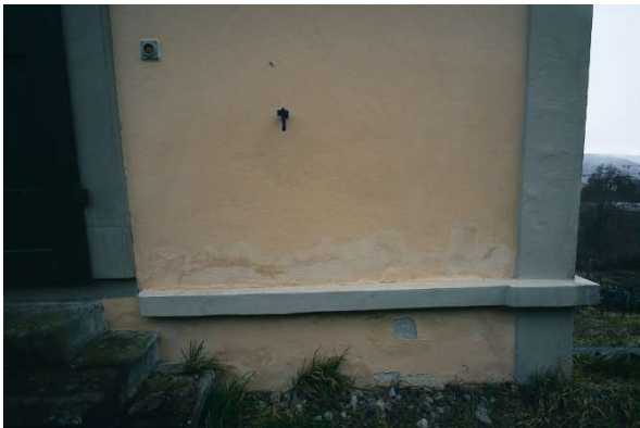
Sockelbereich der Nordseite
