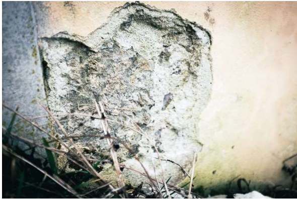
Sichtbares Mauerwerk aus Sandstein im Sockelbereich der Westfassade
