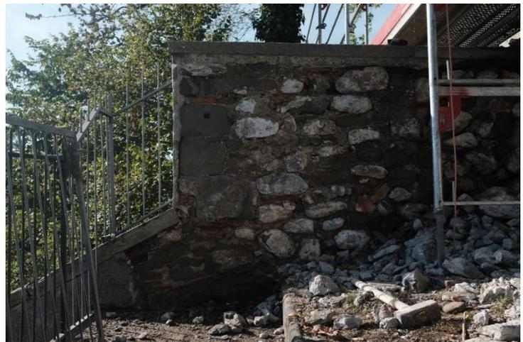
Bild 59: Natursteinmauer während dem entfernen des Zementputzes.
