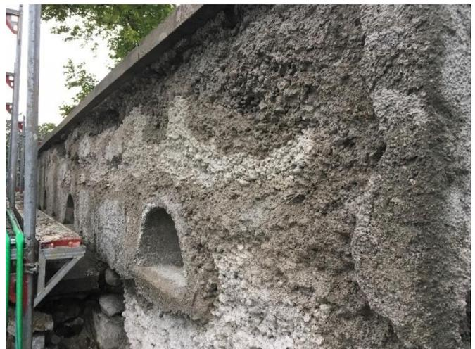
Bild 49: Netzartig aufgetragener Anspritzputz.
