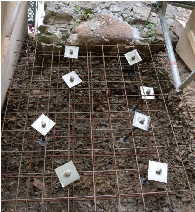
Bild 65: Armierung für die Felssicherung.
