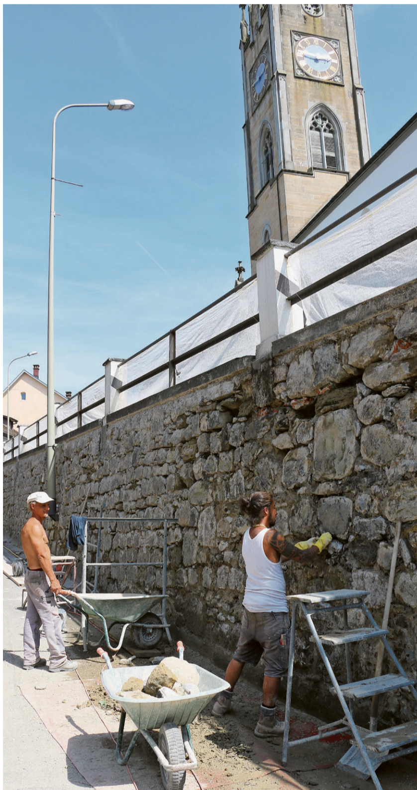
Thomas Neuweiler (hinten mit Schubkarre) und sein Team bearbeiten seit zwei und wohl noch weitere drei Wochen die Stützmauer an der Strehlgasse. Bild: ewa
