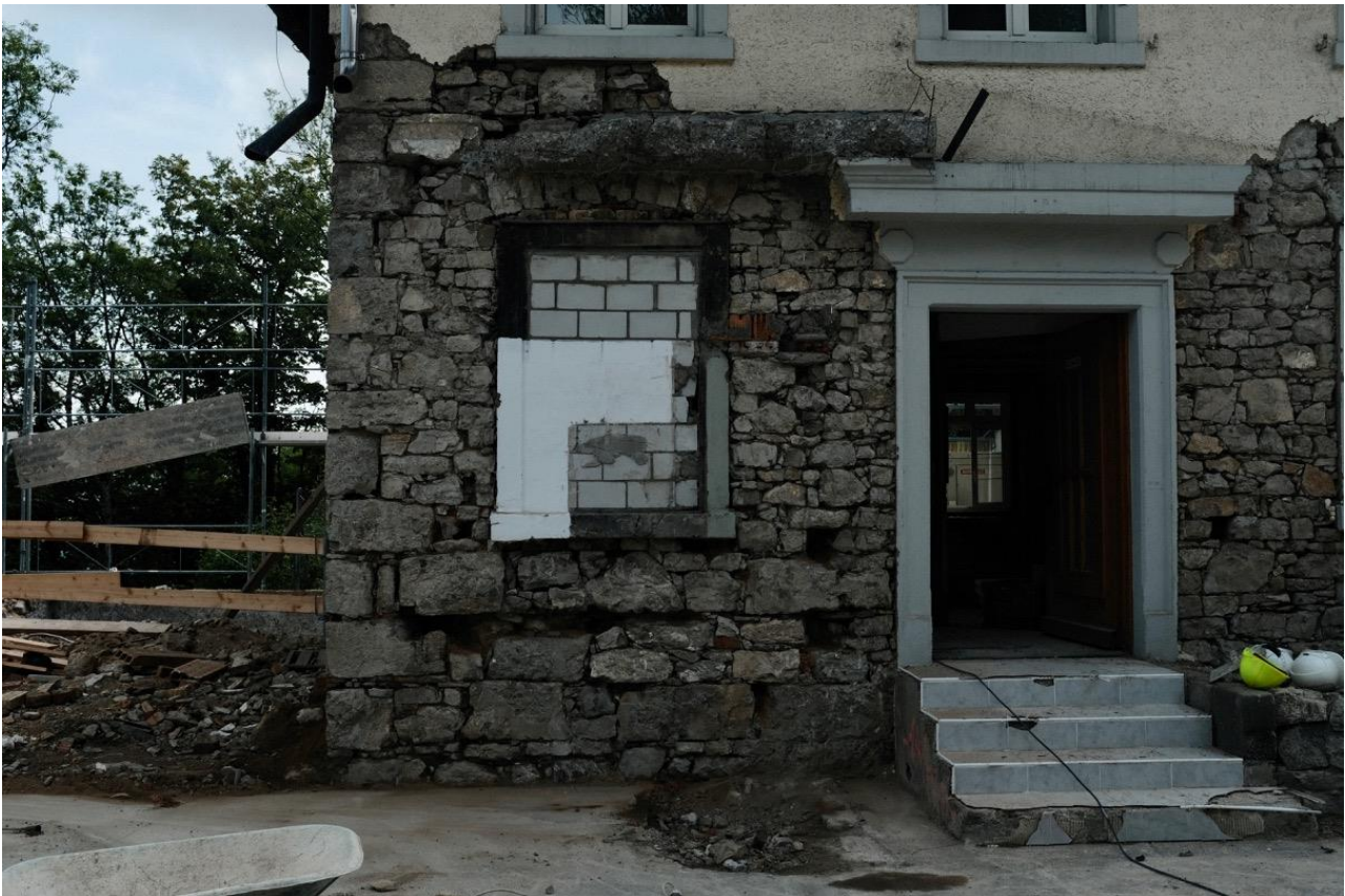
Bild 8: Komplett gereinigtes Mauerwerk. Alle losen Steine und Fremdkörper wurden entfernt.
