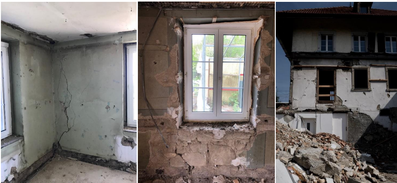
Bild 3-5 : Diverse Setzungsrisse in Putz und Mauerwerk
