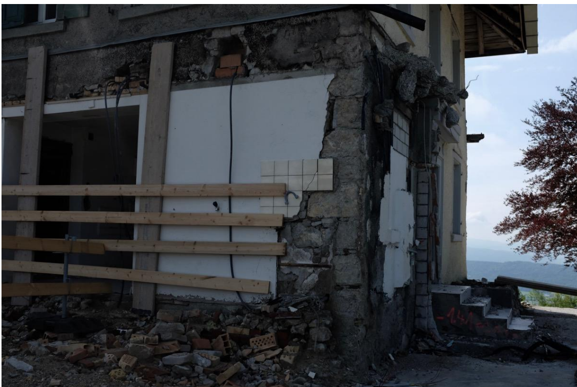
Bild 2: Ansicht der Nordfassade vor der Instandsetzung.
