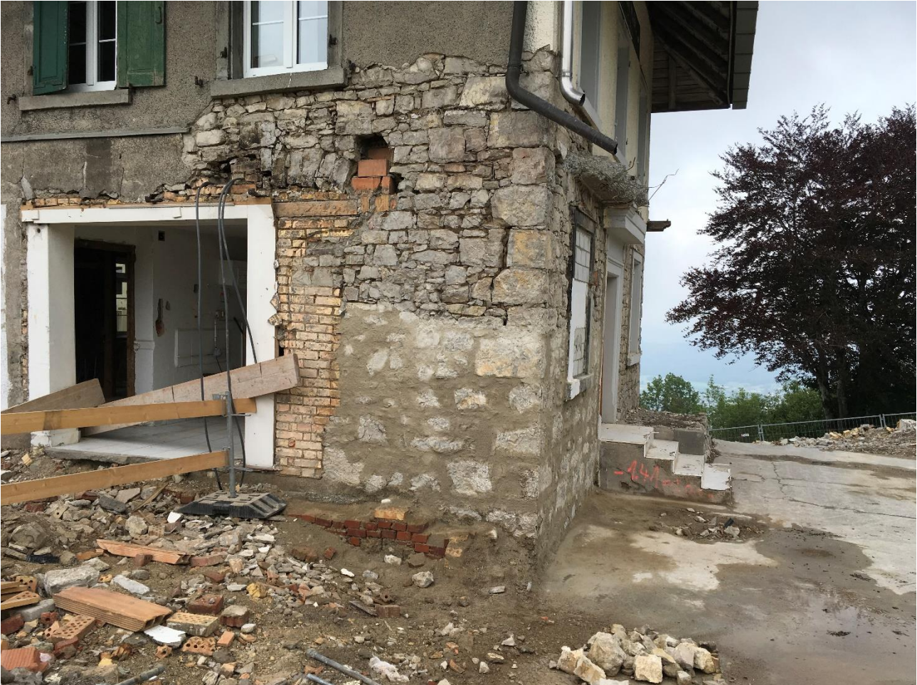
Bild 10: Gestopfte und zurückgekratzte Fläche. Ecke Nord-West.
