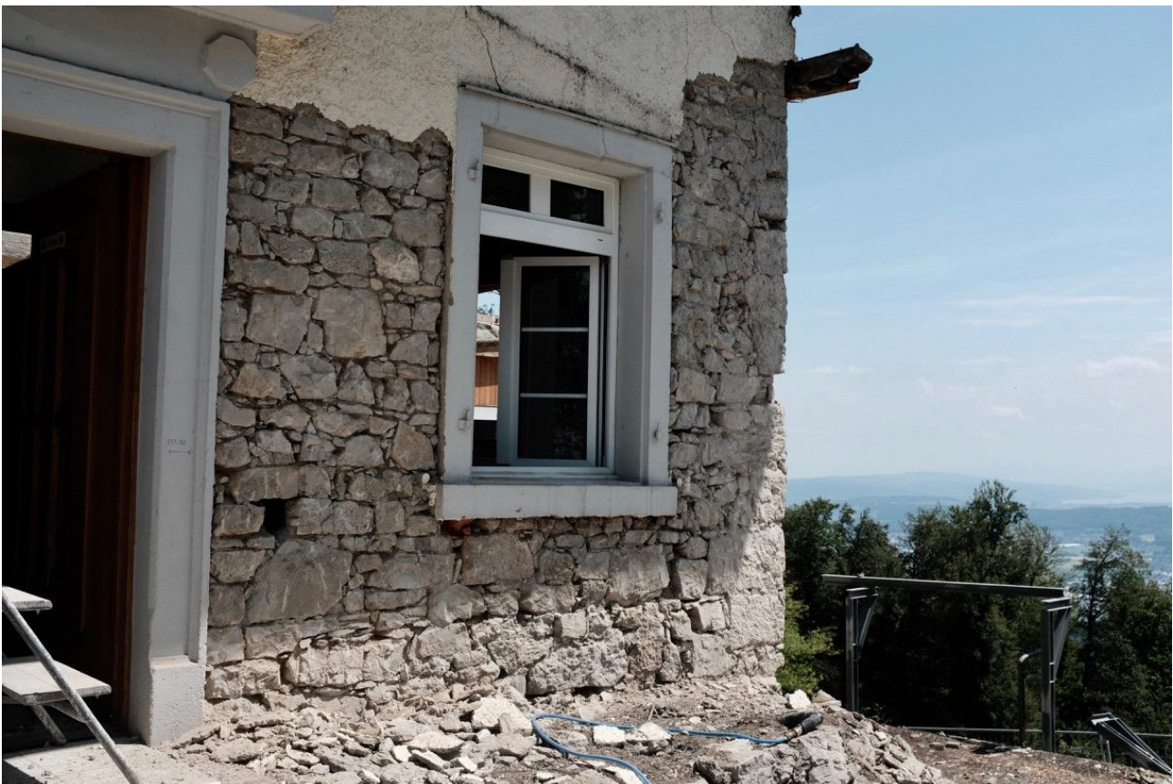
Bild 7 : Freigelegtes Mauerwerk an der Westseite
