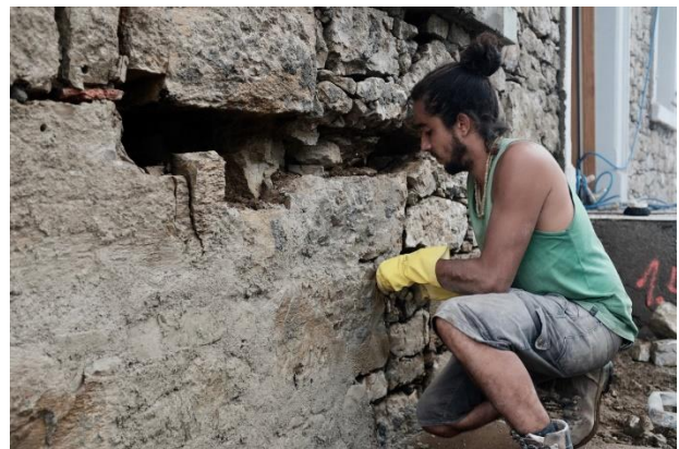
Bild 9: Verpressen des Fugenmörtels von Hand.
