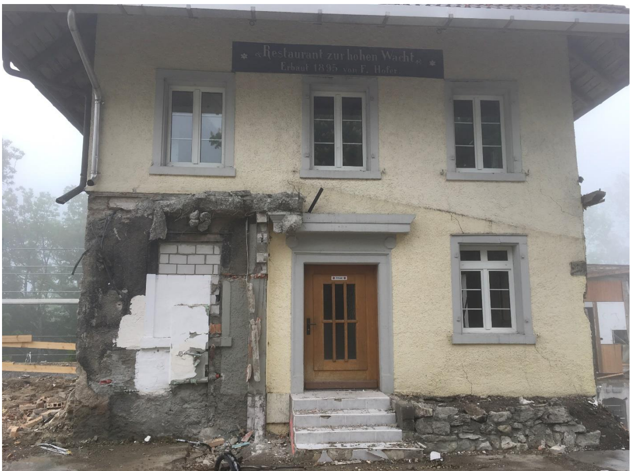
Bild 1: Ansicht der Westfassade vor der Instandsetzung.
