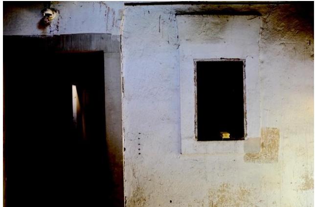
Bild 12: Ansicht der gekalkten Putzoberfläche.
