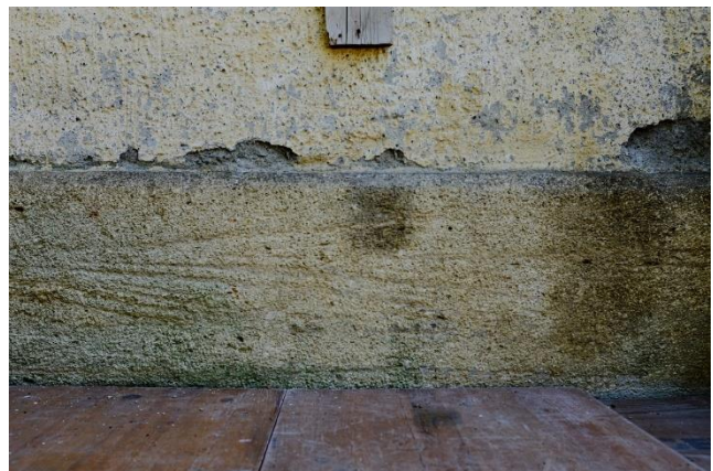
Bild 7: Muschelkalkstein im Sockelbereich
