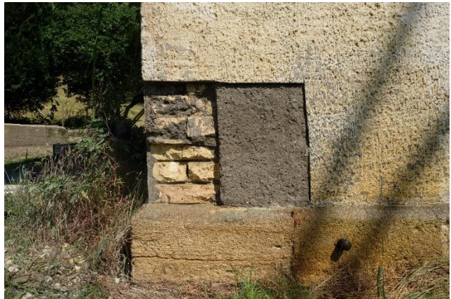
Bild 8: Freigelegtes Mauerwerk Ecke Südwest.
