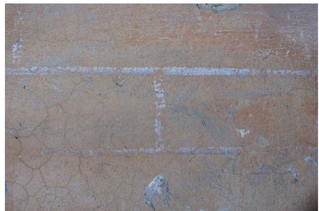
Bild 11: Nahaufnahme eines Fugenstrichs.
