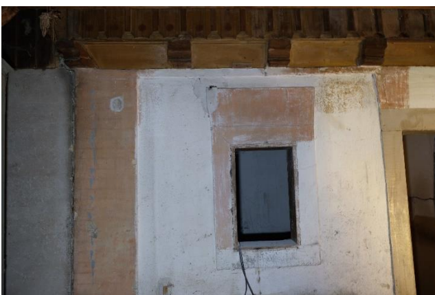
Bild 10: Schwach erkennbare Fugenstriche als Backsteinimitat.
