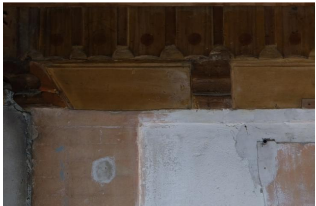
Bild 13: Farbliche Abstufungen auf Holzverschalung.
