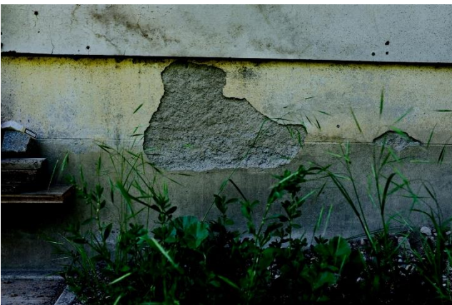
Bild 14: Putzabplatzung
